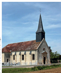
© Commune de Gouffern-Auge
